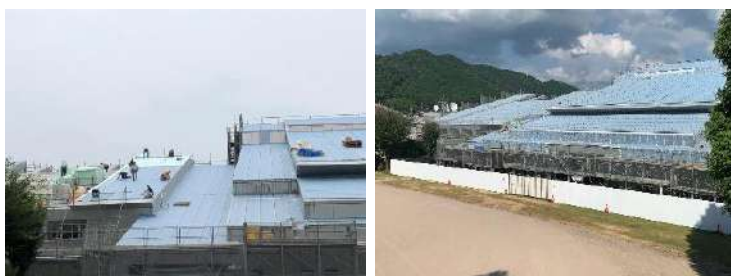
屋根修繕工事
